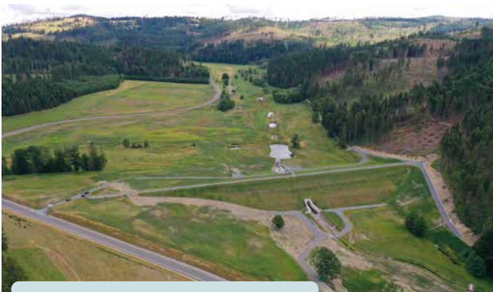
Příklad zhotovené soustavy tůní v zátopě Suché nádrže Jelení na Kobyším potoce v Karlovicích
