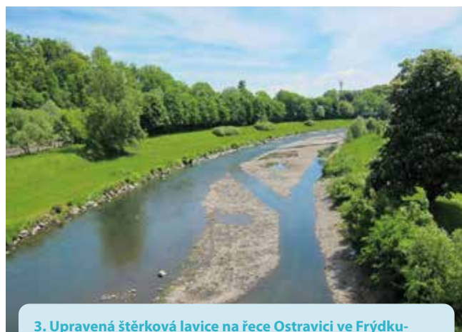
3. Upravená štěrková lavice na řece Ostravici ve Frýdku-Místku rozčleněná vytvořenými rameny a tůněmi. Pohled proti vodě z Koloredovského mostu v ř. km 23.325.
