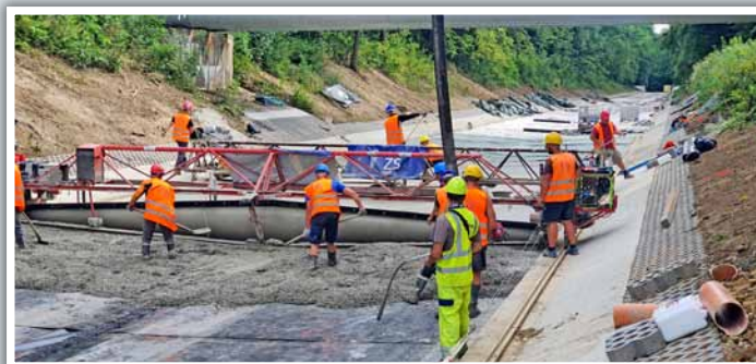
Průběh betonáže dna přivaděče
