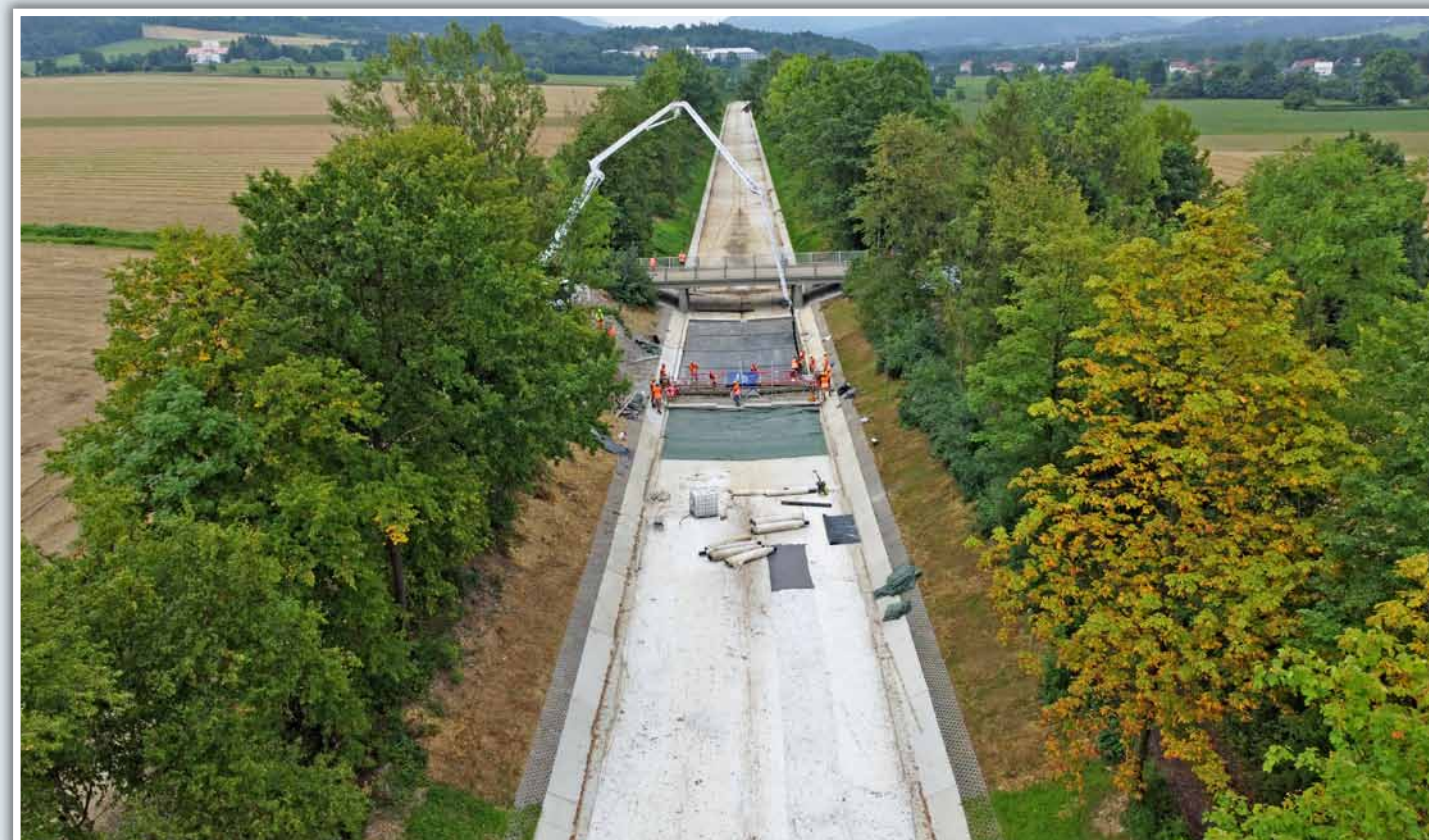
Průběh betonáže dna přivaděče
