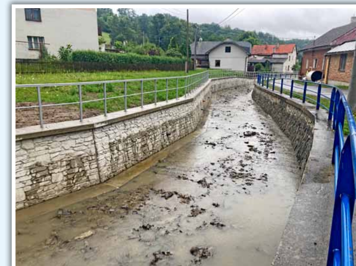
Gručovka v Lukavci - opěrné zdi
