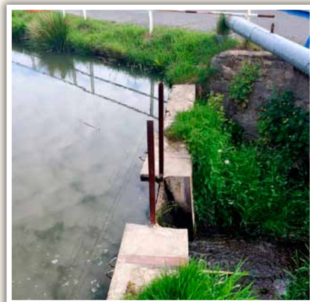
Lužná–Slezské Rudoltice, odstraňovaný vzdouvací objekt
