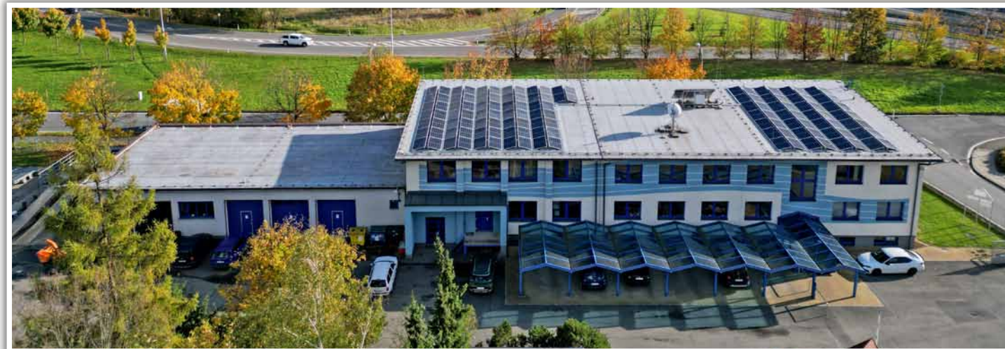
Fotovoltaická elektrárna na závodě ve Frýdku-Místku
