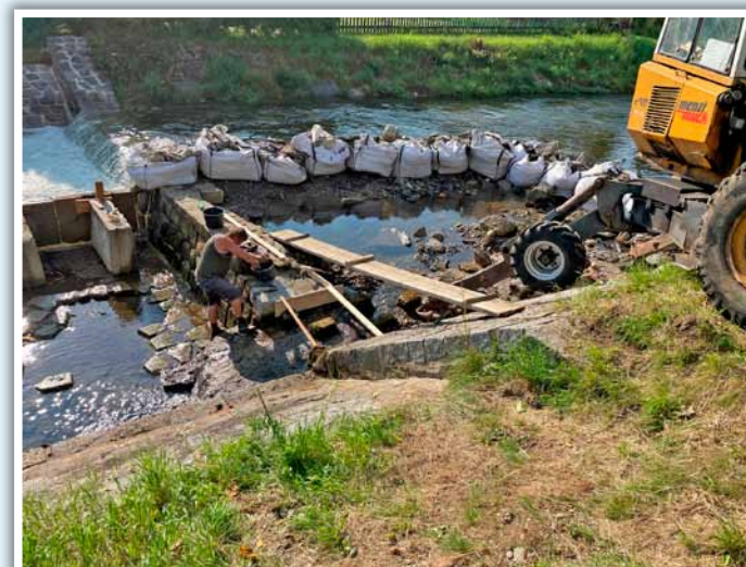
Oprava stupňů na Bělé v Adolfovicích
