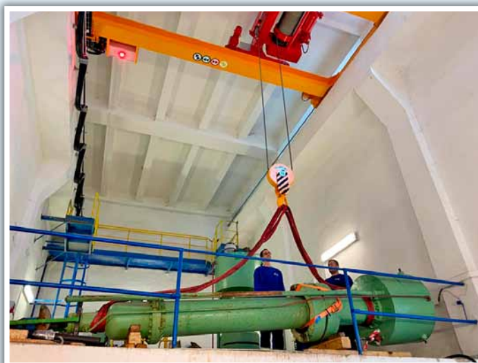
Oprava hydraulického pohonu na okně č. 1 VD Kružberk (zároveň použití nového jeřábu)
