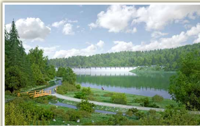
Obrázek č.4 - Vizualizace obtoku zátopy nádrže Nové Heřminovy pro zajištění migrační propustnosti
