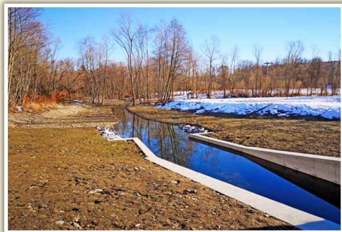
Obrázek č.2 - Přírodě blízká protipovodňová ochrana, obec Karlovice, Zadní Ves
