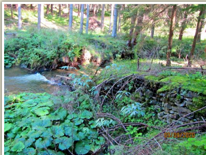
Obrázek č. 5 a č. 6 - Rekonstruovaný spádový stupeň - balvanitý skluz v ř. km 3,243 zajišťující navržený renaturovaný úsek a torzo dřevěného spádového stupně s drátokamennými křídly – ponecháno k renaturaci
