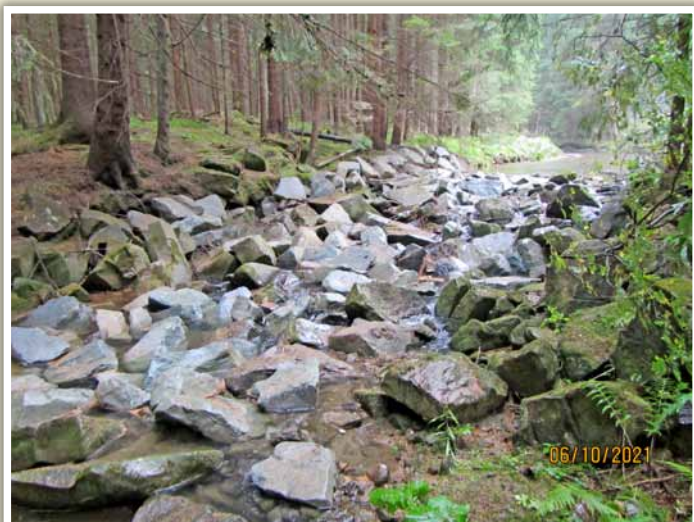
Obrázek č. 5 a č. 6 - Rekonstruovaný spádový stupeň - balvanitý skluz v ř. km 3,243 zajišťující navržený renaturovaný úsek a torzo dřevěného spádového stupně s drátokamennými křídly – ponecháno k renaturaci
