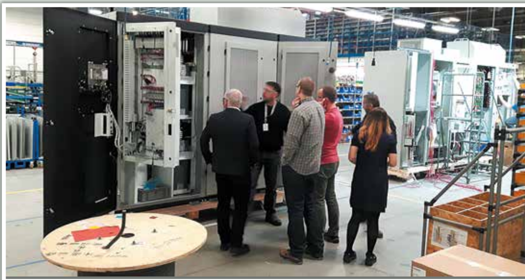
Frekvenční měnič ve výrobní hale Rockwell Automation v Katovicích
