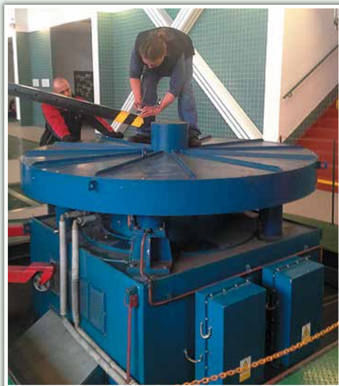
Měření házivosti hřídele turbosoustrojů TG1 na MVE Slezská Harta
