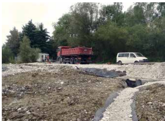
Mycí plocha – čištění vozidel
