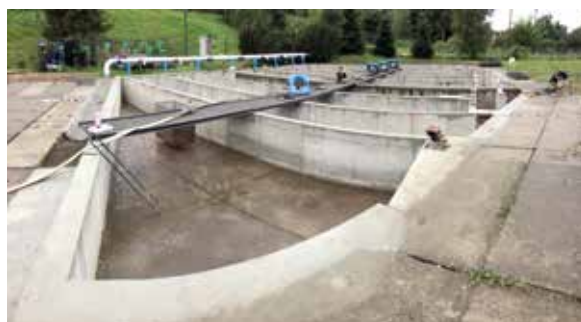
RH Žermanice dělicí stěny
