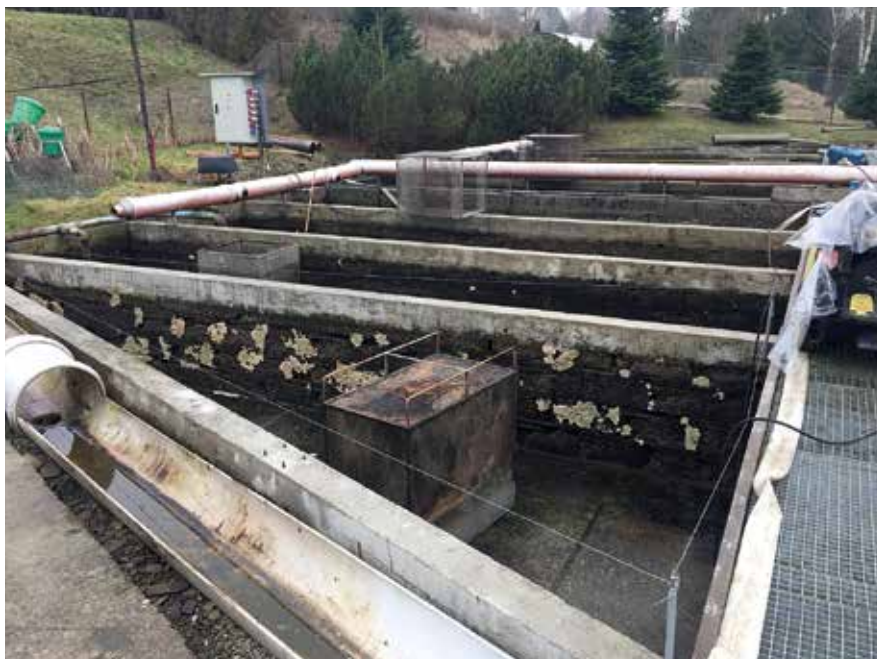
RH Žermanice dělicí stěny původní
