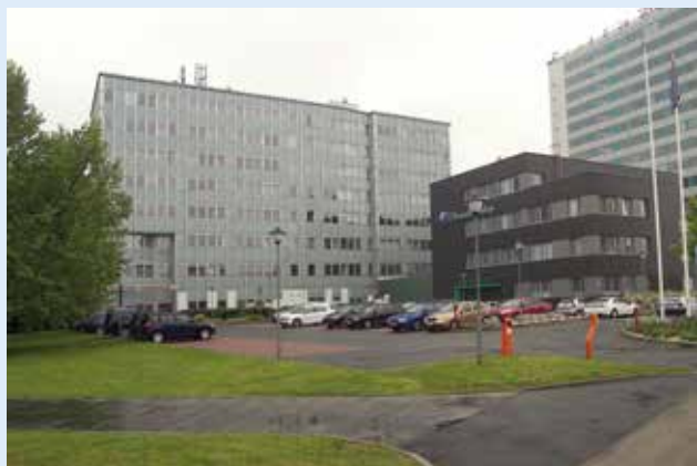
Pohled na budovu před změnou vzhledu...
