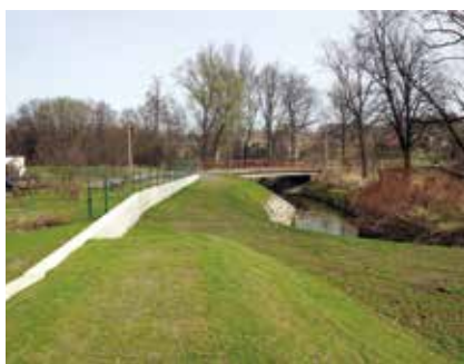
Odsazená hráz se zídou na Petrůvce jako protipovodňová ochrana zástavby Petrovic u Karviné
