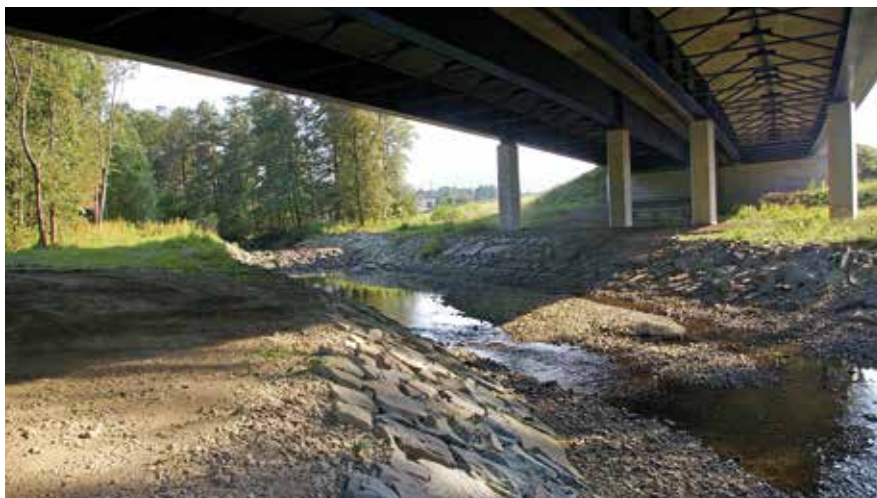
Křižení Stonávky s novou rychlostní komunikací R48 nad Třanovicemi si vyžádalo její dílčí přeložku
