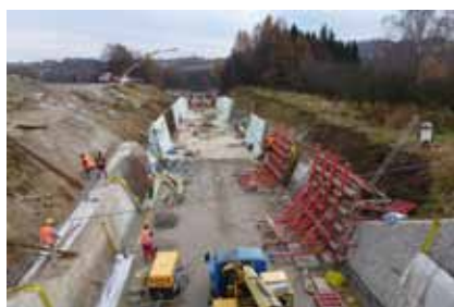
Výstavba nového skluzu
