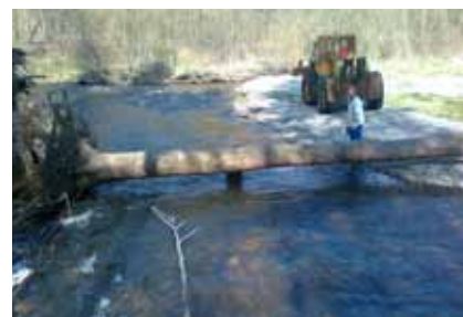
Pracovníci a technika při odstraňování vývratů
