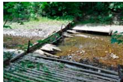
Objekt č. 18 – kombinovaný stupeň v ř. km 2,163
