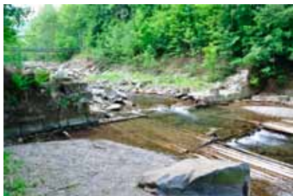
Objekt č. 14 – zděný stupeň v ř. km 1,778
