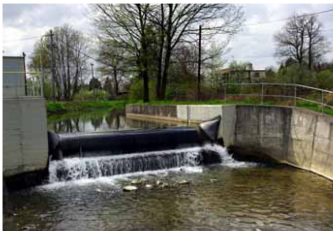
Jez na Porubce – celkový pohled
