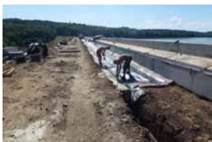
Pokládka hydroizolační fólie
