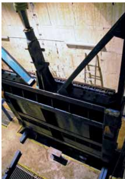
Tabulový uzávěr připravený k opravě
