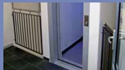
Zrekonstruované vedlejší schodiště v administrativní budově
