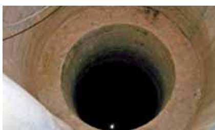
Vyrovňovací komora – pohled zvenčí
