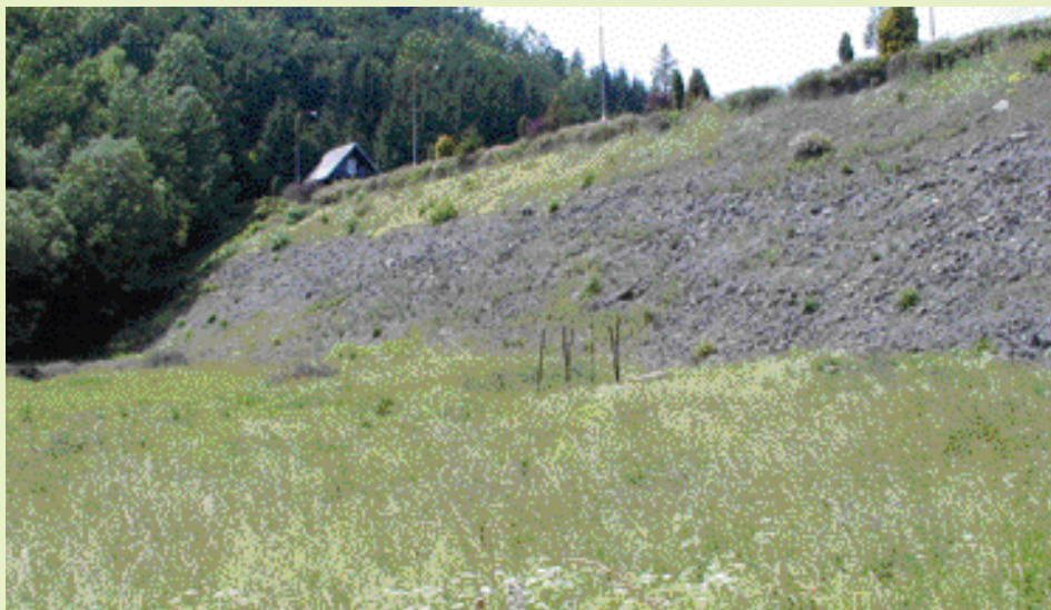
Pohled na hrázi
