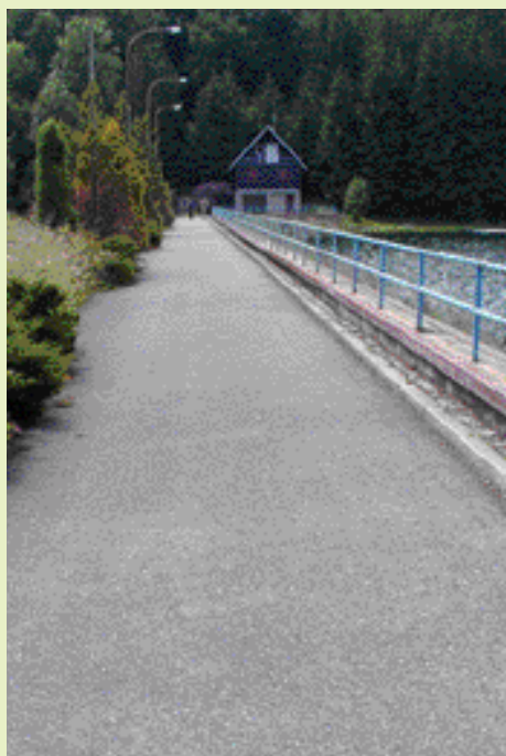
Pohled na hrázi
