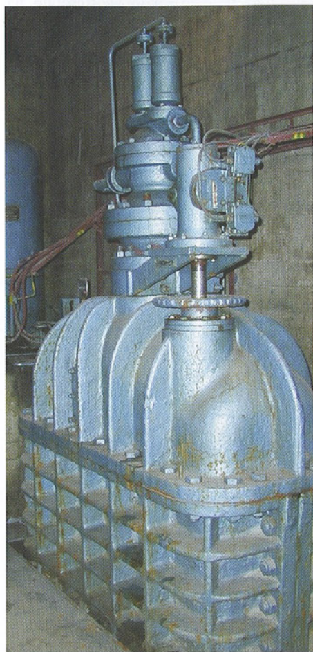
Rozstříkovací uzávěr DN 1100
